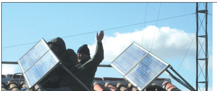
Montage des panneaux (F6DHI, F11GVK)
