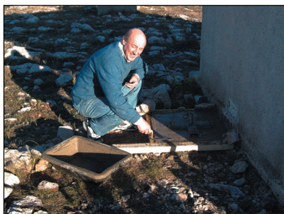
Préparatif de l'assise du pylône au nord du local (F5DKJ)
