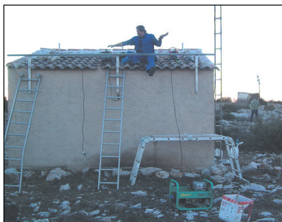
Réalisation du support métallique (F6JKL, F11GVK)
