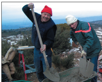
Réalisation de la chape béton F6DHI, F1MMT, F5DKJ)
