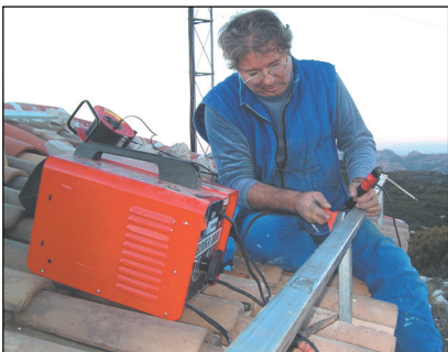
Soudure en place (F6JKL)
